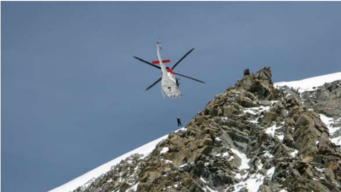
Fasi di installazione dei tabelloni fotogrammetrici
