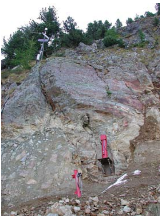
Estensimetri per misurazione frana Becca di Nona
